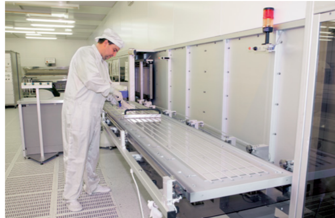
クロム膜コーティング用クリーンルーム設備
